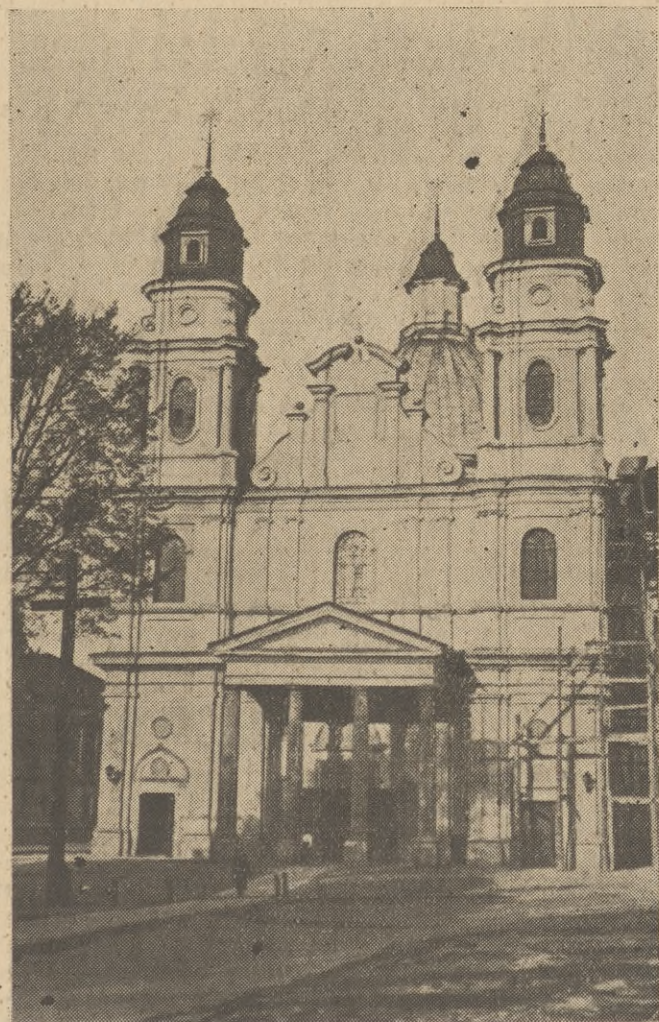
Katedra Chełmska w odbudowie.
